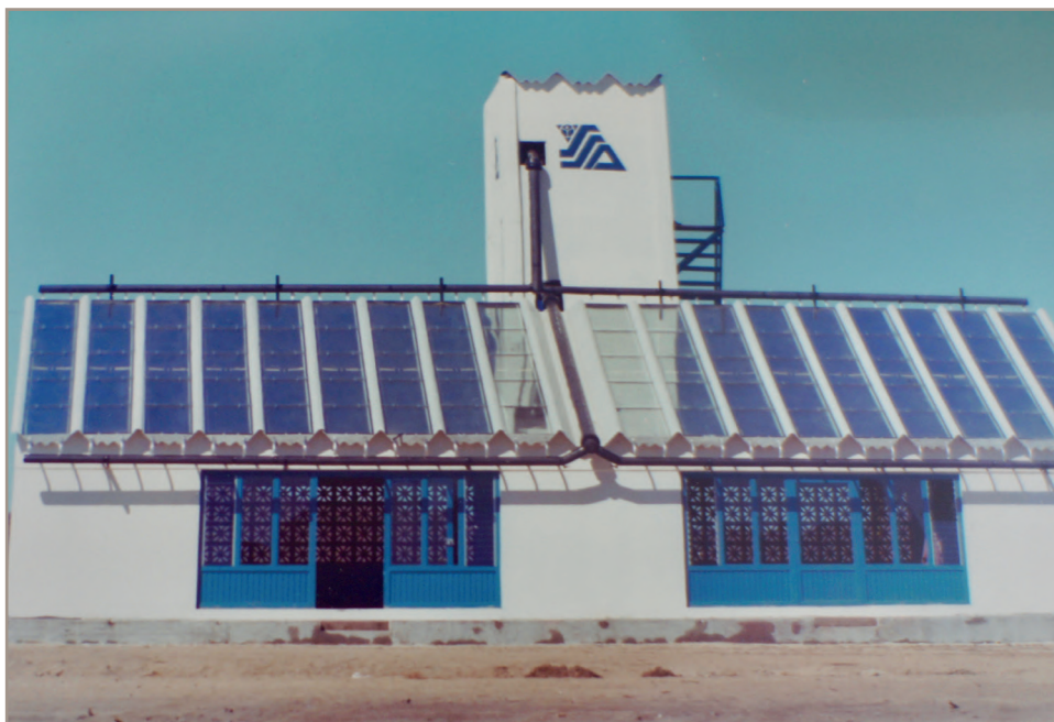
Image 3 - Station de pompage solaire Sofretes de Todo Santos en 1976 (Mexique, Basse Californie, capacité de pompage de 50.000 litres/jour)
